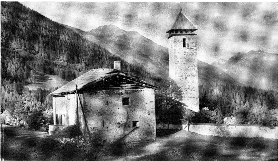
Abb. 6 Das Hospiz in Capella vor dem letz- ten Umbau. Ansicht von Südwesten. (Cliché: Zeitschrift «Schweizer Ju- gend»).
