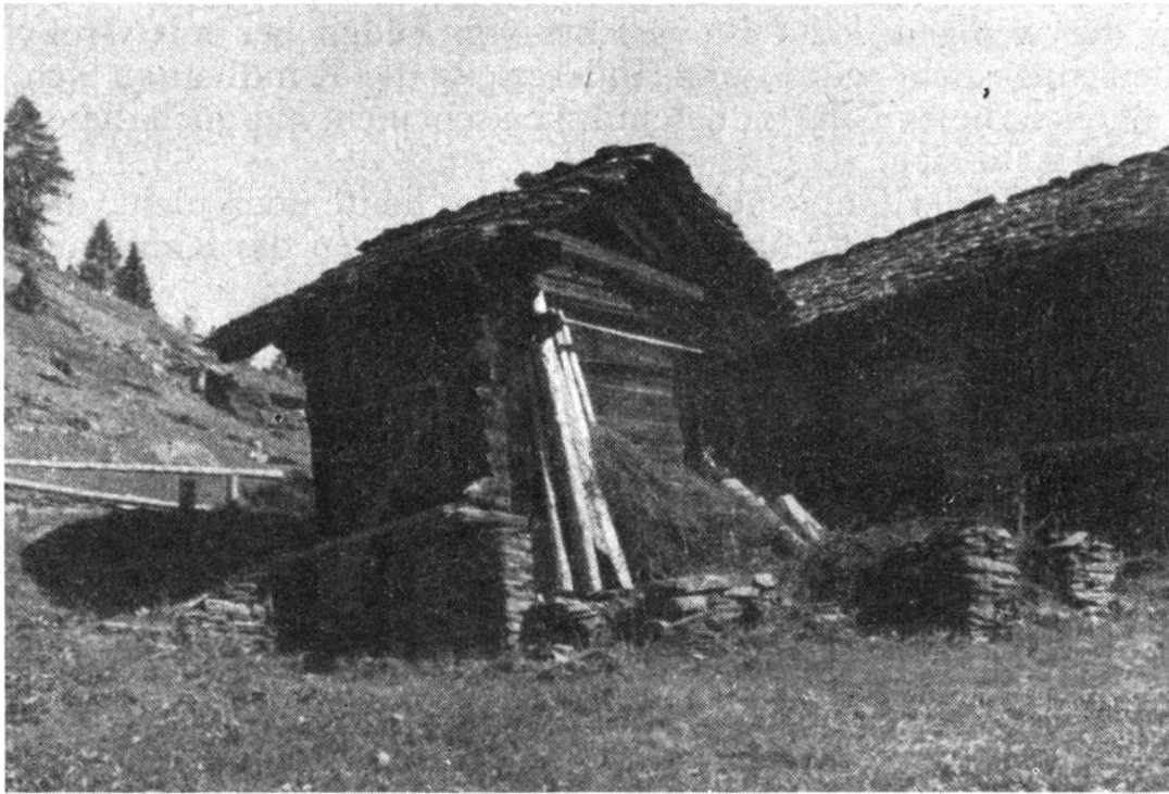
Abb. 1. Schlafhaus im Monte Valbella (Calanca, Kt. Graubünden). Fast quadratischer Kantholzblock mit stark ausladendem Pfettendach. Der gemauerte Unterbau dient als Keller. An der Traufseite findet sich die Türe, erreichbar über eine kleine Laube. An der Giebelseite bemerkt man die kleinen Fensterlucken, sowie Reste eines Trockengestells.
