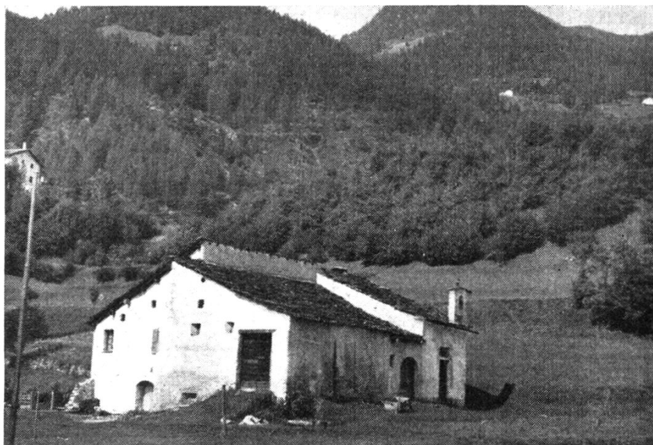
Abb. 2. Bauernhaus von 1674 in Viale, St. Antonio, Puschlav, ca. 1000 m ü. M. Gegenüber dem Wirtschaftsgebäude liegt der Wohntrakt ( Casa civile ) weiter zurück. Die beiden Gebäude sind verschieden hoch.
