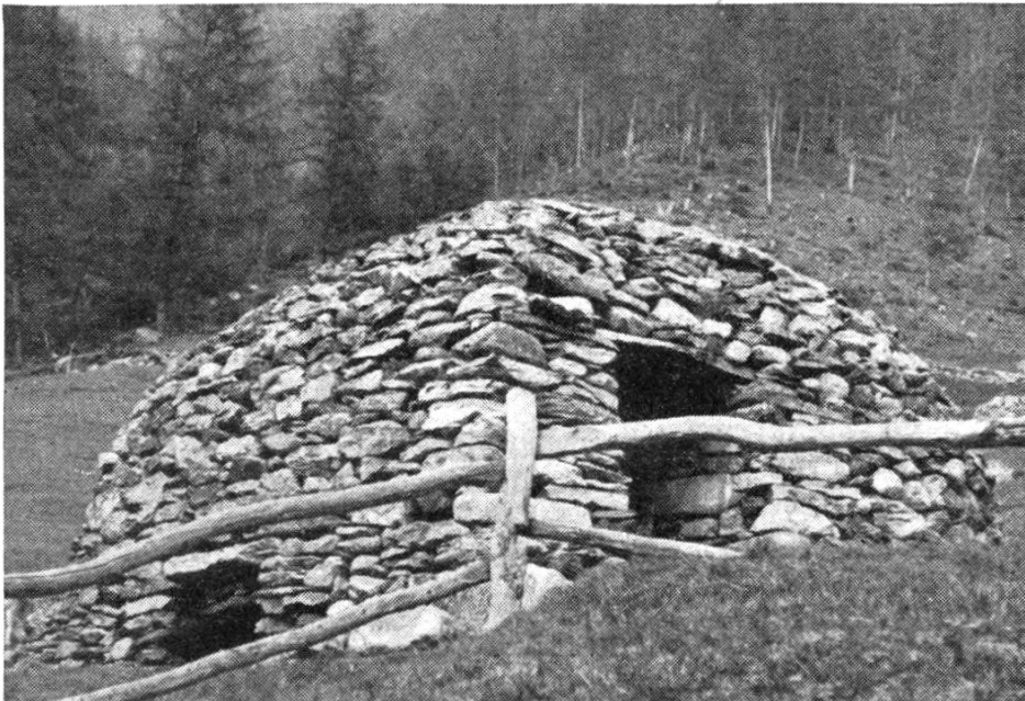
Abb. 9. Rundbau auf Alpe Braga, südöstlich Viano, 1700 m ü. M. mit Aufgliederung des Innenraumes in Stall und Scheune (funktioniert als Casa rustica ).
