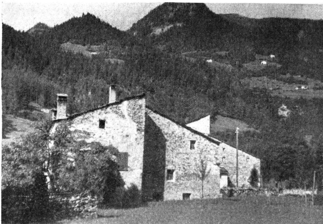
Abb. 1. Bauernhaus von 1701 in Viale, St. Antonio, Puschlav, ca. 1000 m ü. M. In der Giebelfront ist die Gliederung in zwei verschiedene Teile, in das Wirtschaftsgebäude rechts und das Wohngebäude links, sehr deutlich sichtbar.
