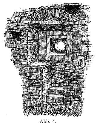
Von diesem Stockwerk führte auch je eine Türe in die Abteile I und III. In letzterem trat man durch die einzige im ganzen Bau rundbogig überwölbte Türöffnung direkt in die Herrenwohnstube, in der der schon erwähnte Ofen stand. Diese Türöffnung scheint nachträglich ausgebrochen worden zu sein, denn unmittelbar rechts daneben ist eine Stichbogentüre zugemauert.
