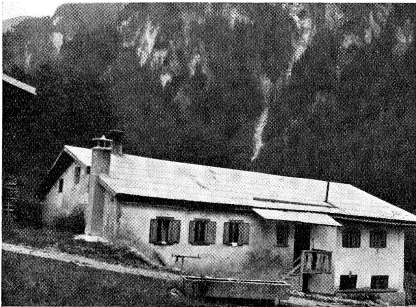
Haus in Safien-Platz, im obern Teil auf den Fundamenten der alten Johanneskirche
