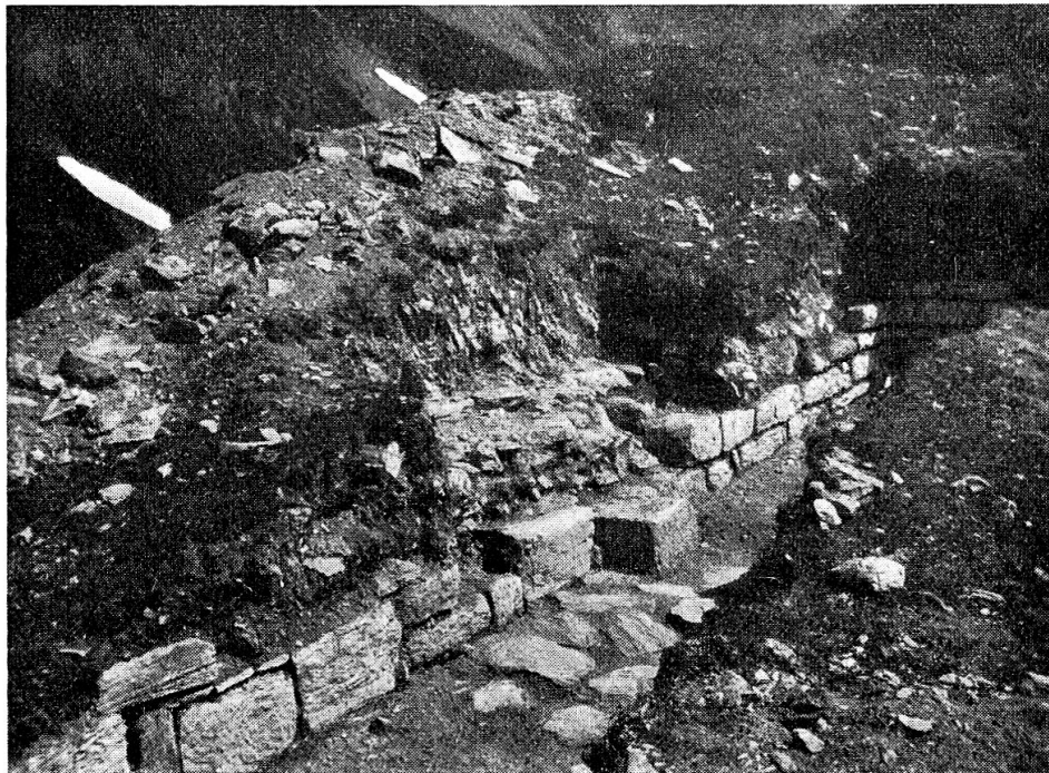
Abb. 3. Ostwand des Nordraumes. Mauermantel, Mauerkern, Sockel, Steinplatten-Bodenbelag.
