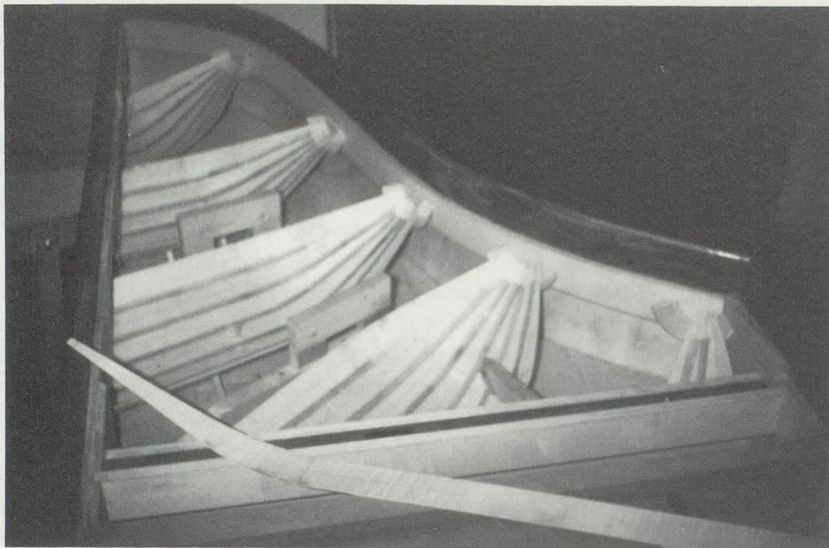
Abb. 1: Lautenartige Spänung im Innern des Instruments während des Baues.
