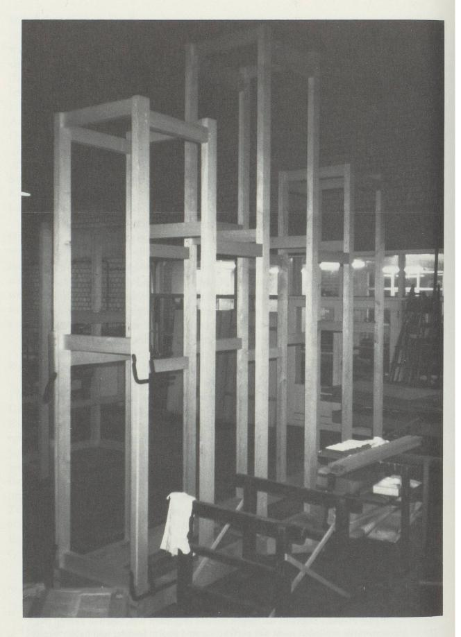
Abb. 2: Die Ständer-Bau-Konstruktion des Gehäuses (Foto: Edskes).
