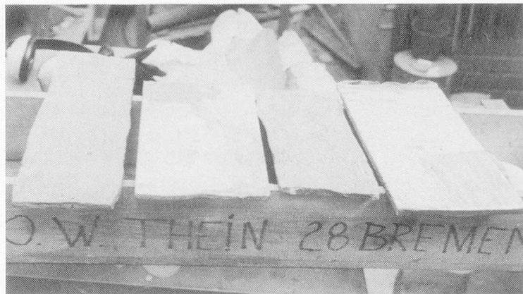
Abb. 14: Messingbarren, die in einer plattenartigen Kokille gegossen wurden. Maße: 330 x 210 x 12 mm. Diese Kokillengröße erwies sich als sehr günstig für das Blechschmieden, während z. B. für die Saitenherstellung eher strangartige Kokillen angezeigt sind.
