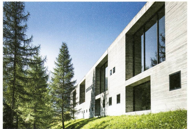
Die nach Nordosten Richtung Dorfausgang ausgerichtete Fassade der Therme wirkt dank der unterschiedlich grossen Fensterflächen leicht und bietet den Badegästen eine unvergleichliche Nähe zur Natur. (Foto: Global Image Creation – 7132 Hotel, Vals, 2017)
