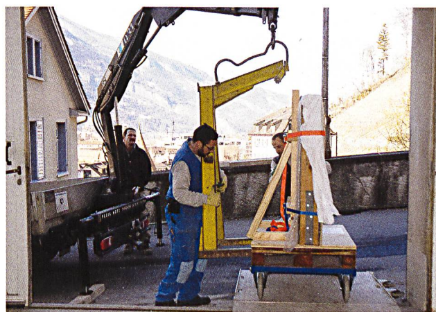
Die bis zu 300 kg schweren Gefache wurden 2005 für den Transport und für ein besseres Handling bei der Untersuchung und Bearbeitung auf Rollwagen montiert. (Foto Doris Warger)
