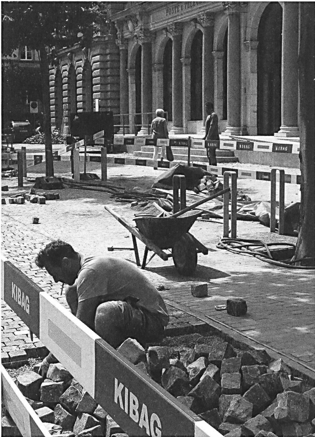
Umgebungsarbeiten vor Eröffnung der Stadtbibliothek. Ein Arbeiter von «Anliker – Pflästerungen» setzt die letzten Steine. (Foto P. Metz 11.8.2018)
