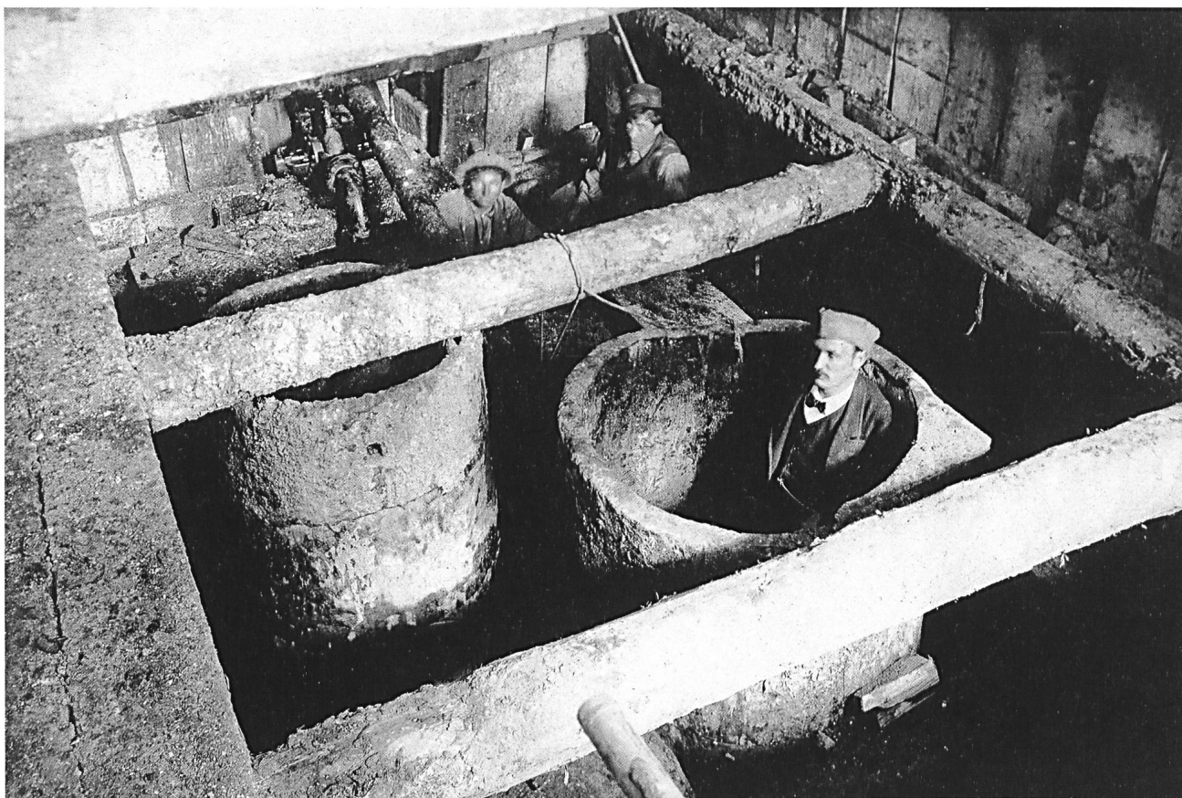
Die Lärchenstämme der ersten, rund 3500 Jahre alten Quellfassung wurden 1907 geborgen. Im Bild: Architekt und Bauführer Christian Gartmann in der «Röhre 2» während der Bergungsarbeiten. (Foto: Archäologischer Dienst Graubünden)
