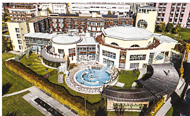
Das BES fügt sich unaufgeregt in das Dorfbild ein. Es besteht aus fünf Hauptteilen mit Innen- und Aussenbädern mit reinem Mineralwasser, Solebecken, Whirlpool, Kalt- und Warmwassergrotten, dem römisch-irischen Bad, Saunalandschaften, Dampfbädern, Panoramaruheräumen sowie Liegewiesen und den Gesundheits- und Therapieräumen. Der Bau besticht durch die Verbindung traditioneller Farbgebung in Pastelltönen mit modernster Technik. (Foto: Bogn Engiadina, Johannes Fredheim)
