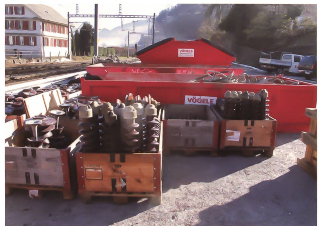
Rückbau SBB Hochspannungsmasten, Lagerplatz von Claudia Schmid, 2016. (Fotonachweis: © C Schmid)
