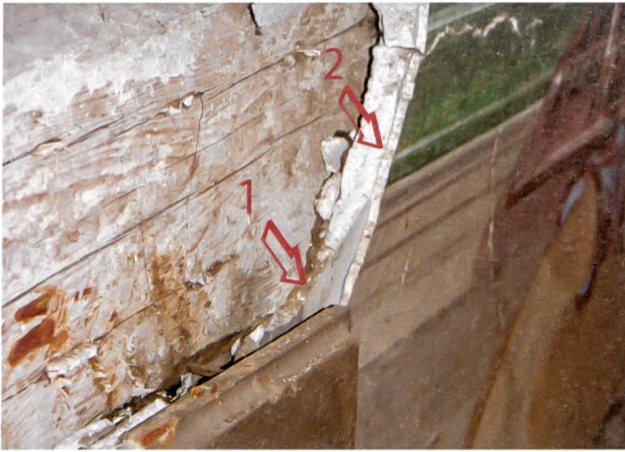
Nachweisbarer Schichtaufbau über Holzbalken, der als Haftbrücke mit dem Beil angehackt wurde.
