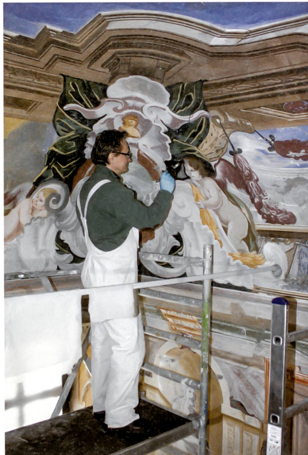
Christoph Tinzl festigt Malschichten durch Pinselauftrag der Festigungslösung über einer Japanpapier-Zwischenlage.
