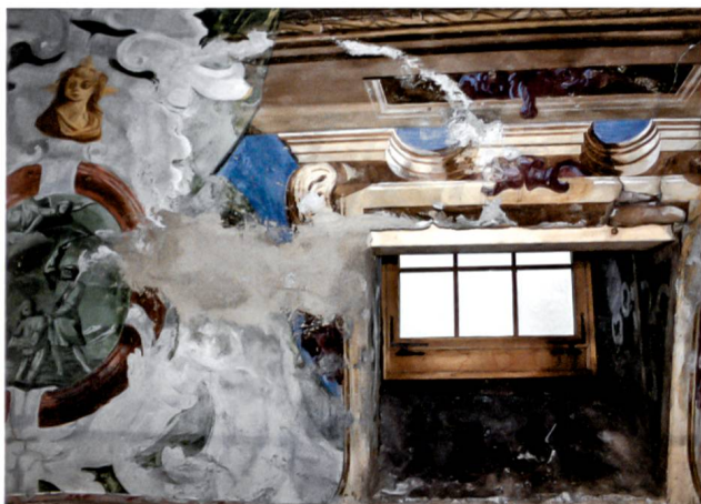
Durch Feuchtigkeit (Infiltration) bedingte Erosion (bis hin zu vollständigen Verlusten) bei der Voute der Westseite.
