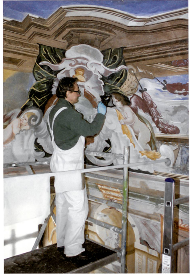
Christoph Tinzl festigt Malschichten durch Pinselauftrag der Festigungslösung über einer Japanpapier-Zwischenlage.
