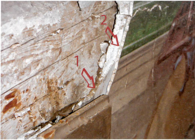
Nachweisbarer Schichtaufbau über Holzbalken, der als Haftbrücke mit dem Beil angehackt wurde.
