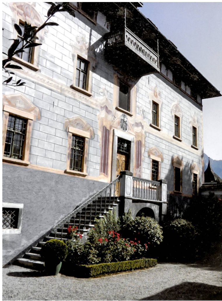
Treppenaufgang auf der Westseite. (Foto Beat Kilchenmann)
