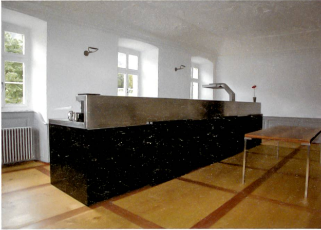
Kücheneinbau in der ehemaligen Bibliothek im 1. OG.
