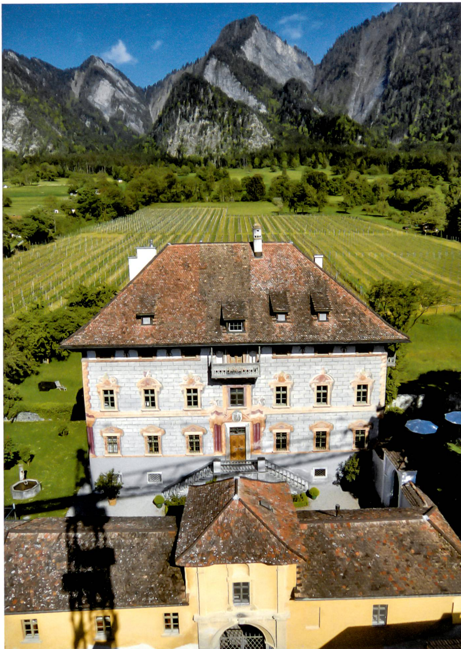
Westansicht «Oberes Schloss» mit vorgelagertem Portalhaus und Innenhof. (Quelle: Beat Kilchenmann)
