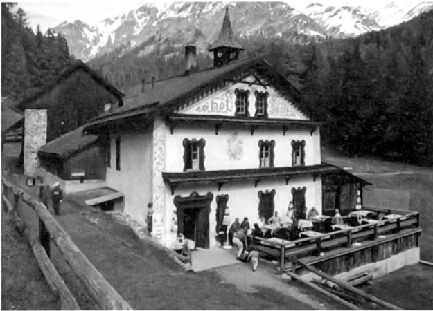
Hof und Gasthaus Zuort, erbaut von einem Taverna aus Sent nach einem Brand des Vorläufergebäudes, ab 1875. (Foto J. B.)
