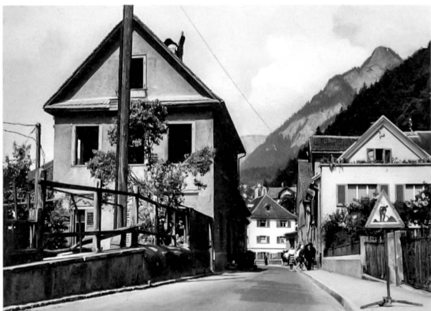
Haus links: Alte Krippe an der Steinbruchstrasse in Chur ab 1915; kurz vor dem Abbruch im Jahr 1961. (Foto Baupolizei Stadt Chur; Quelle: StC FA 023, S. 19)
