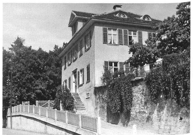
Haus «Sonnenberg» an der Masanserstrasse 110 in Chur.
