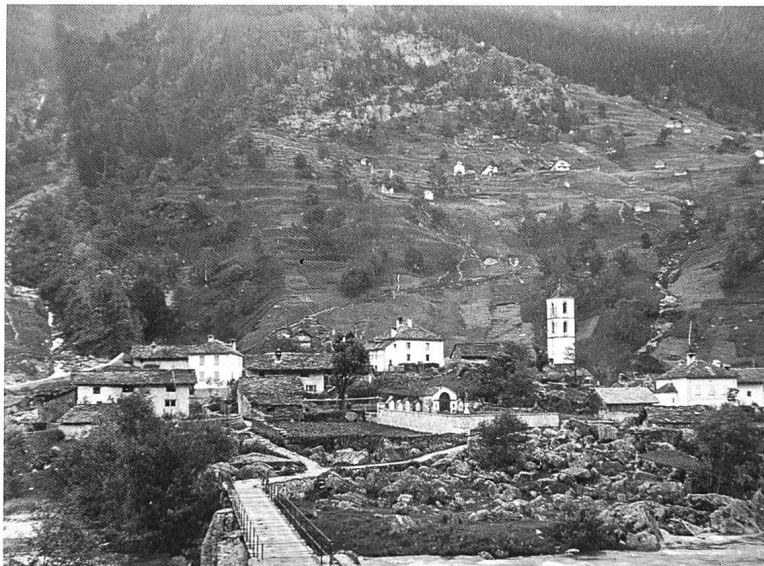
Alte Ansicht des Dorfes Cauco mit Brücke und Friedhof. (Quelle: Archivio regionle Calanca; Bild: Oskar Good)
