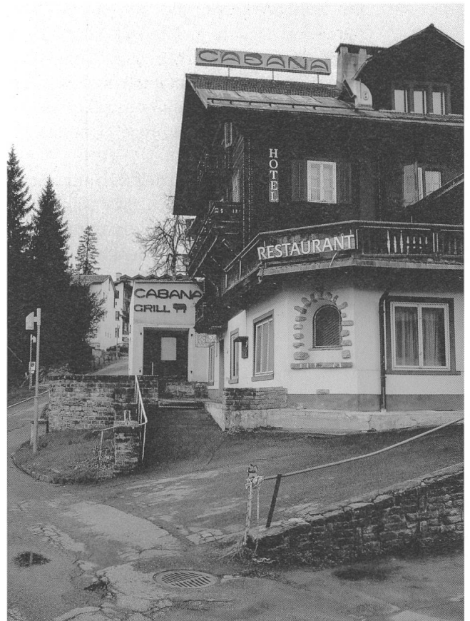
Kino im Cafe Grob, später Hotel Cabana, Via Teissa 2, Flims Waldhaus. Links der Saalanbau von ca. 10 x 6 m Grösse. Kino 1955 bis 1962 im Saal für ca. 30 Personen. (Foto P. Metz, 2014)
