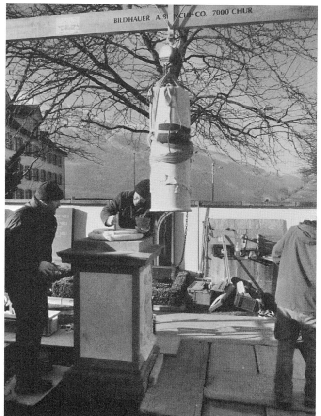
Die Säule wird angemörtelt und gesetzt.
