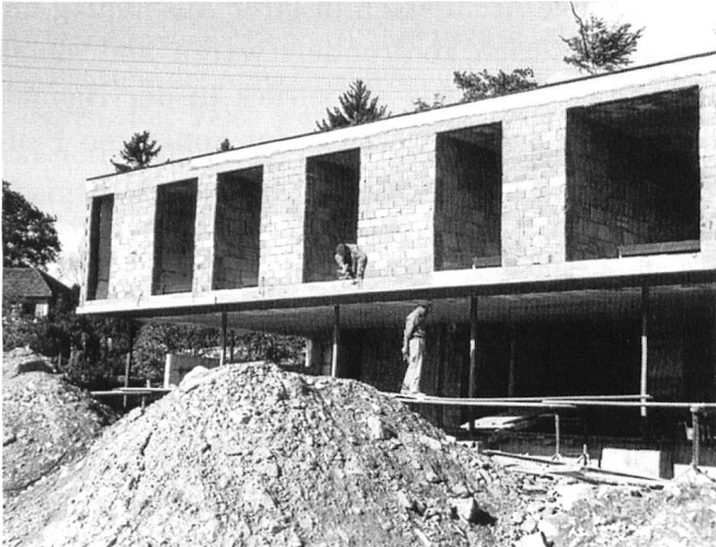
Das Haus Zinsli im Bau 1959–1961, Sicht auf die zum Tal gerichtete Westseite. (Quelle: Pb. VZ)
