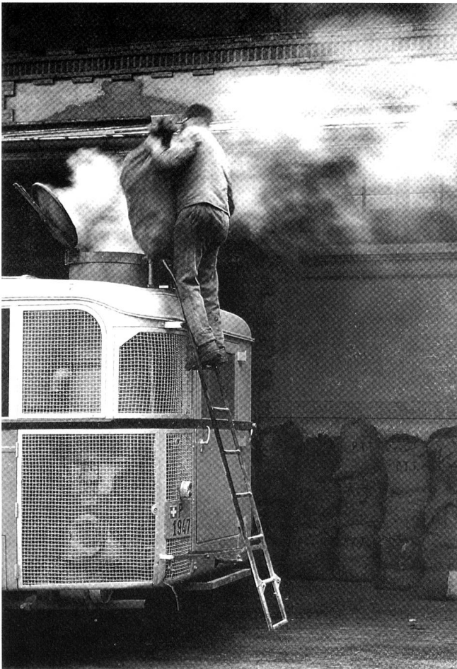
Holzvergaser beim Aufladen 1942. (Quelle: 75 Jahre Postauto, 57)
