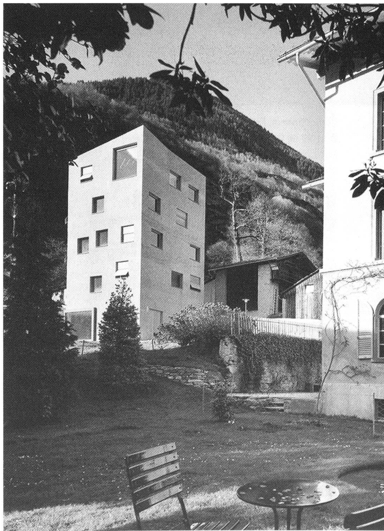
ETH Denklabor Villa Garbald nach Abschluss der Erneuerung und Erweiterung durch die Architekten Miller&Maranta und die Landschaftsarchitektin Jane Bihl-de Salis, aufgenommen im März 2004. (Foto Ruedi Walti, Basel)
