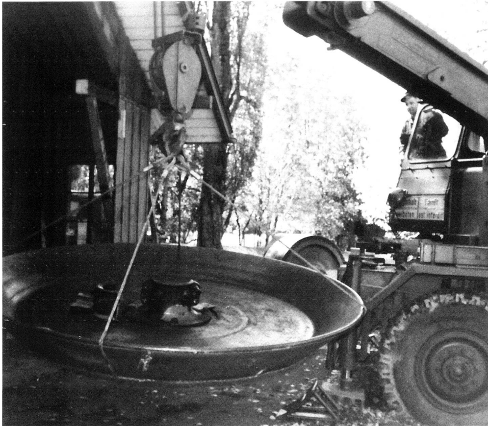
Ausbau des Läufers Nr. 3 zum Abtransport nach Aubonne VD im Jahr 1976. (Foto in Pb. von Hans Kocher, Chur)
