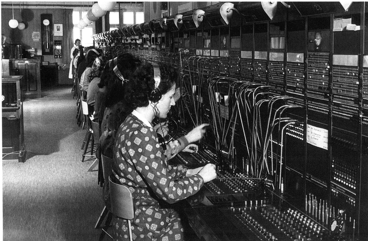
Die St. Moritzer Zentralbatterie-Zentrale, 1929–1952. (Foto: Telecom PTT Chur).
