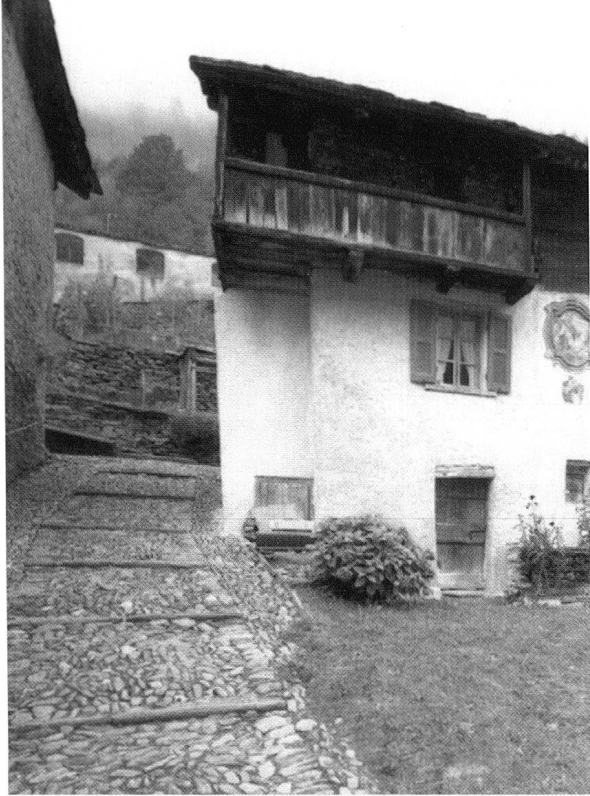
Abb. 29. Vertikalverbindung mit wild verlegter Schropfenpflasterung. Foto: DPG.
