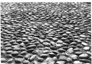
Abb. 32. Bollenpflästerung mit Flusssteinen Neuere Pflästerungsarbeiten. Foto: DPG.
