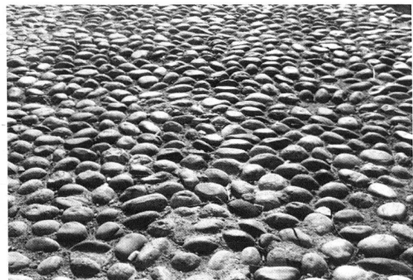
Abb. 32. Bollenpflasterung mit Flusssteinen Neuere Pflasterungsarbeiten. Foto: DPG.
