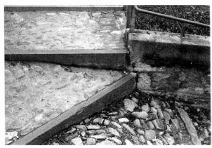
Abb. 38. Fugen mit Mörtel ausgegossen (Fugenbild unschön, da Steinanteil sinkt und Fugenanteil wächst).
