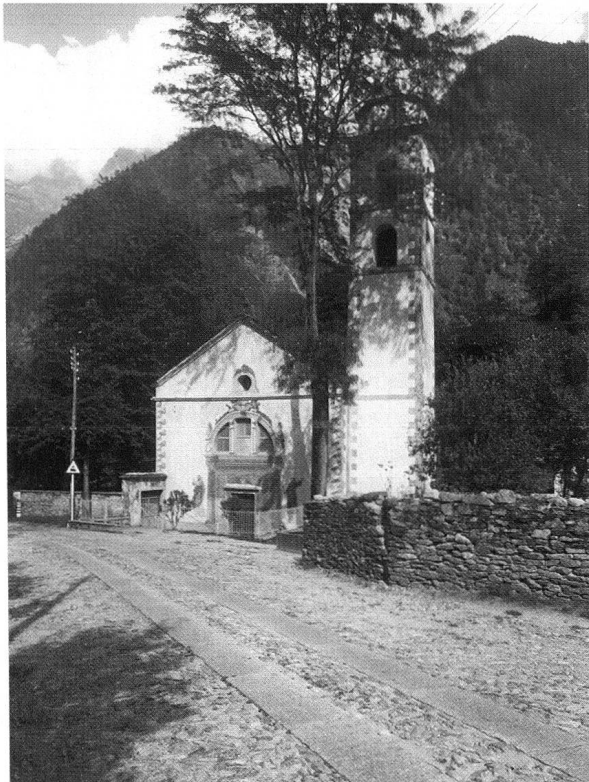
Abb. 31. Der Belag der Kantonsstrasse von 1860 bei San Rocco. Foto: Eidg. Archiv für Denkmalpflege, Bern (Fotosammlung Zinggeler).
