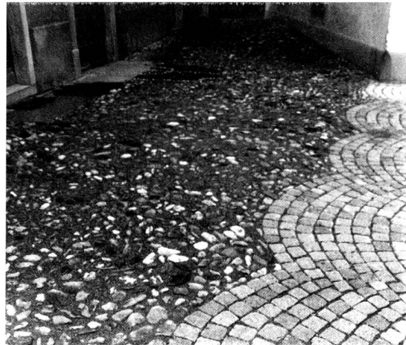
Abb. 20: Bivio. Übergang zur Gassenpflasterung in Bollenstein-Ausführung.
