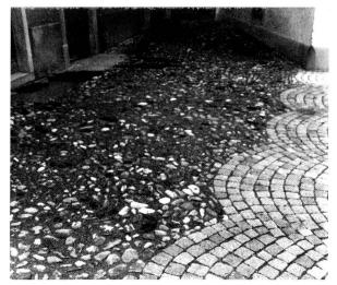
Abb. 20: Bivio. Übergang zur Gassenpflästerung in Bollenstein-Ausführung.
