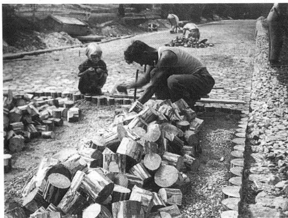
Abb. 5: Holzpflasterung bei Cazis im Jahr 1936.
