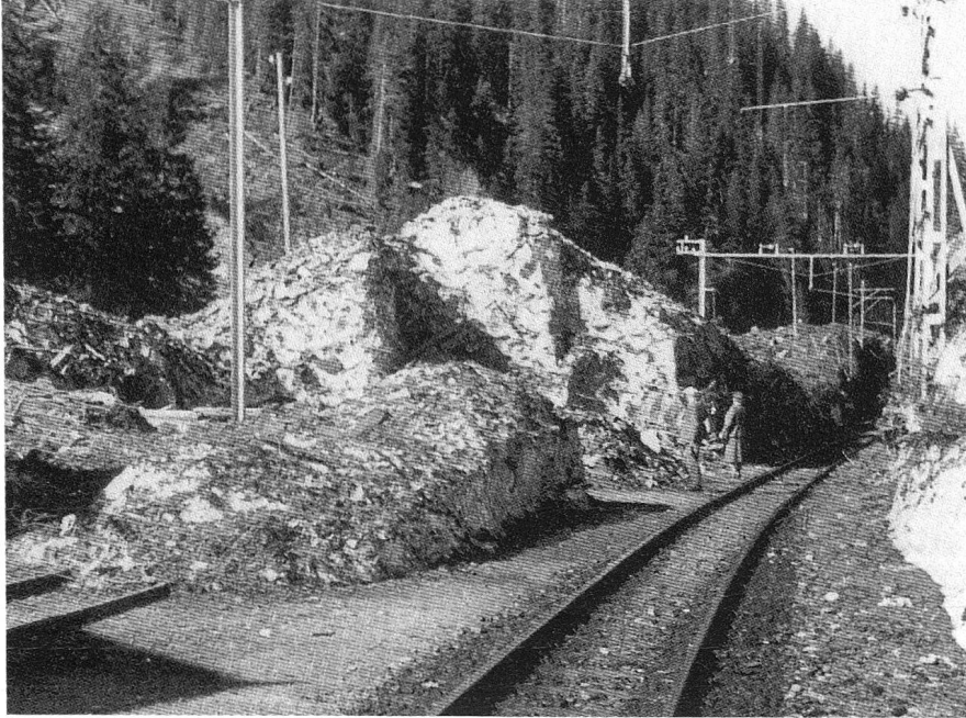
Am 20. Januar 1951 gingen bei Davos Monstein mehrere Lawinen zu Tale. Die erste davon zerstörte das Stationsgebäude.
