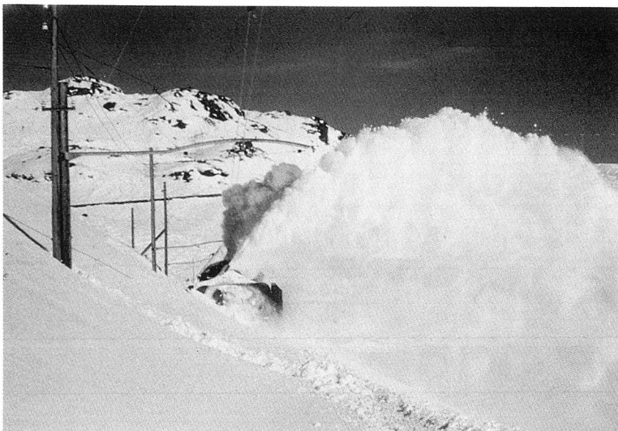
Die Dampfschneescheuler in voller Aktion im Berninagelände. Vorne die riesige Schneegischt und davor der dunkle Rauch des Dampfbetriebes.
