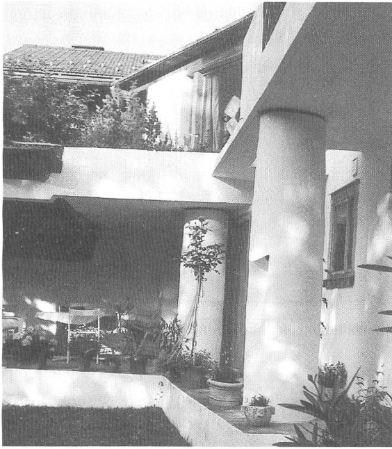
Echte Olgiati-Säule: Zentrierendes, nicht tragendes Element.
