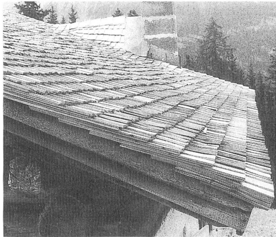
Ein fertig verlegtes Schindeldach.
