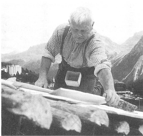
Die Schindeln werden verlegt.
