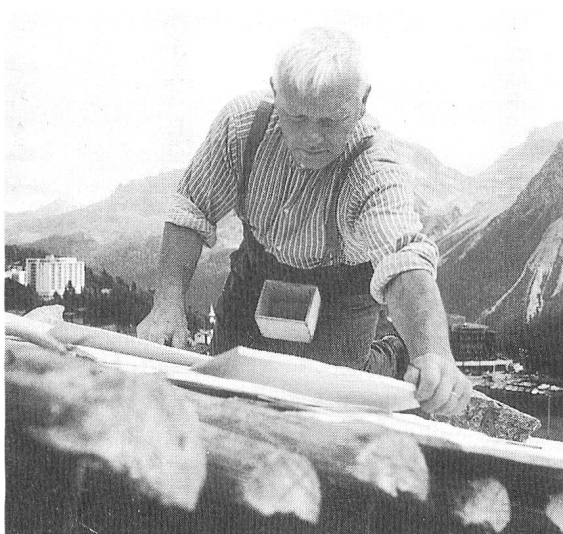
Die Schindeln werden verlegt.
