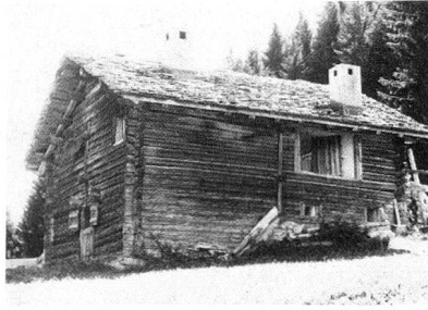
Umgenutzter Stall in Magù. Links: Süd-Ost-Ansicht. Die alte Stalltüre dient heute als Fensterladen. Mitte: Nord-Ost-Ansicht. Die Fenstereinbauten in der Nordfassade, als wären sie schon immer so gewesen. Rechts: Süd-West-Ansicht. Das grossflächige Fenster in der Südfassade dient 3 Wohnräumen.
