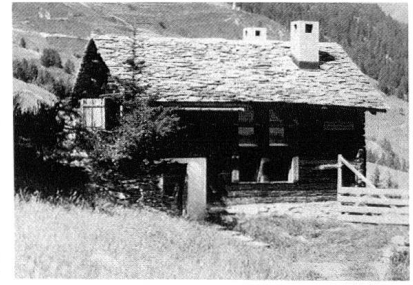
Umgenutzter Stall in Magù. Links: Süd-Ost-Ansicht. Die alte Stalltüre dient heute als Fensterladen. Mitte: Nord-Ost-Ansicht. Die Fenstereinbauten in der Nordfassade, als wären sie schon immer so gewesen. Rechts: Süd-West-Ansicht. Das grossflächige Fenster in der Südfassade dient 3 Wohnräumen.
