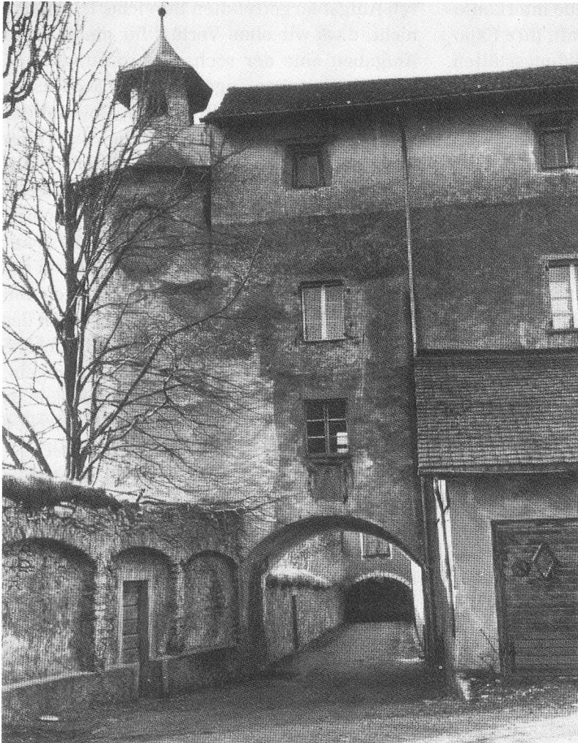
Kopfende des Nordtraktes von Schloss Haldenstein. Deutlich erkennbar ist das nach dem Brand von 1732 aufgesetzte dritte Geschoss, das der Schülerschaft des Seminars Haldenstein als Schlafgemach diente. In den unteren Stockwerken fand der Unterricht statt. (Foto Th. Hartmann, reproduziert in: Jenny und Hartmann: Schloss Haldenstein, Chur o. J.)
