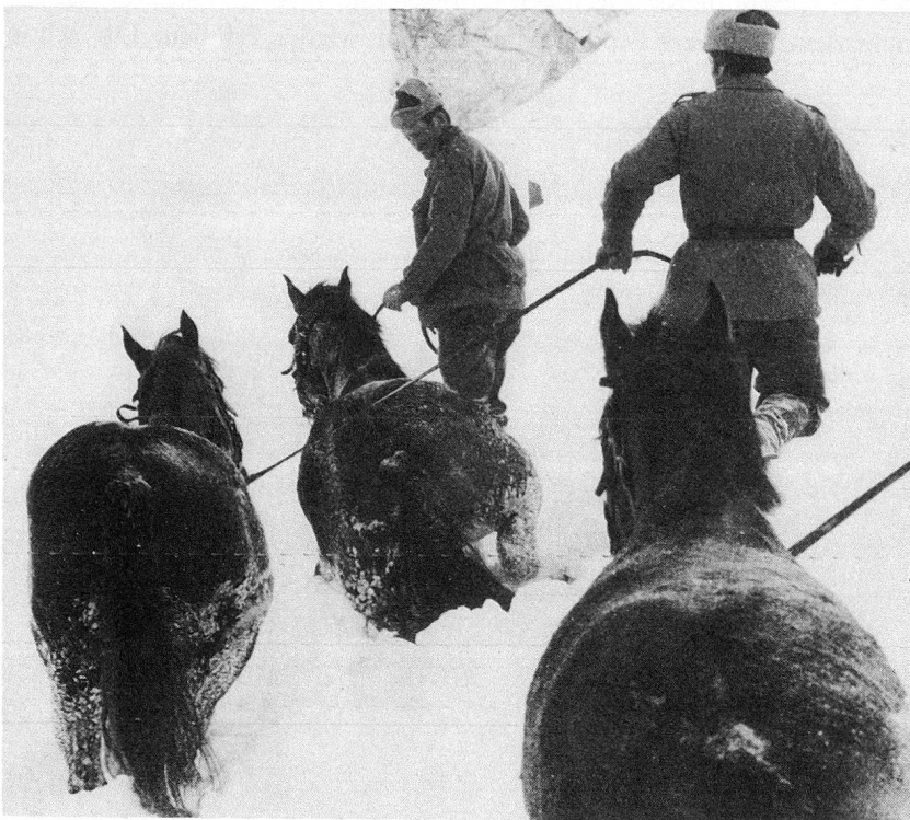
Als Spurpferde dienen ruhige, kräftige, breitbrüstige Tiere. Sie verdichten mit ihrem Körpergewicht die Spur. Wegen Verletzungsgefahr gehen sie barfuss, das heißt sie tragen keine Hufeisen.
