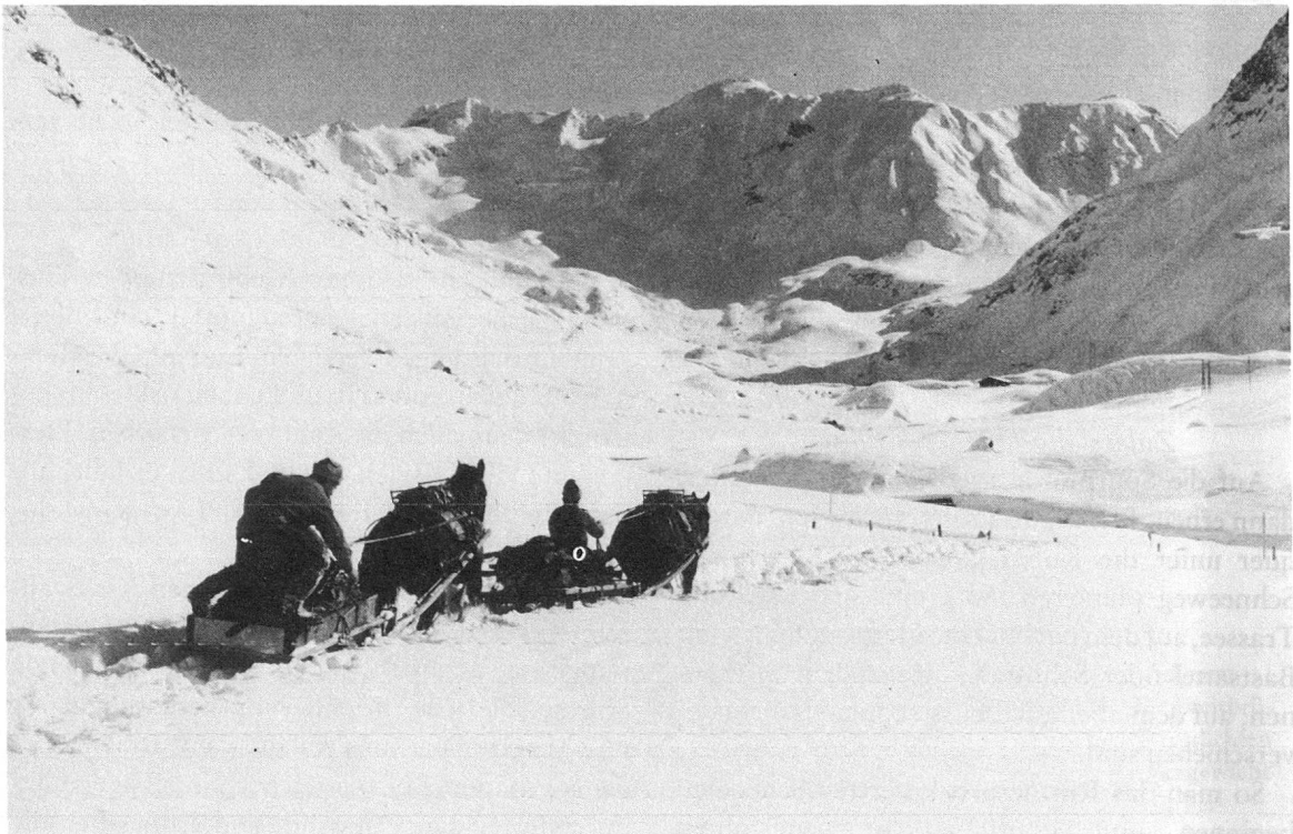
Die fertig geruttnerte Schlitten- und Saumpiste sollte annähernd gleich hoch sein wie die umgebende Schneedecke, damit sie nicht vom Winde verweht wird. Sie benötigt ständigen Unterhalt.
