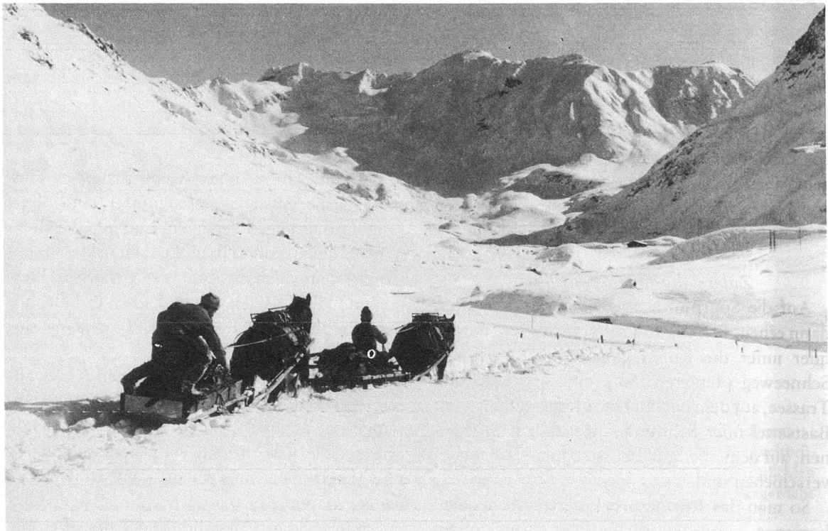
Die fertig geruttnete Schlitten- und Saumpiste sollte annähernd gleich hoch sein wie die umgebende Schneedecke, damit sie nicht vom Winde verweht wird. Sie benötigt ständigen Unterhalt. (alle Bilder: Fritz Heinze)
