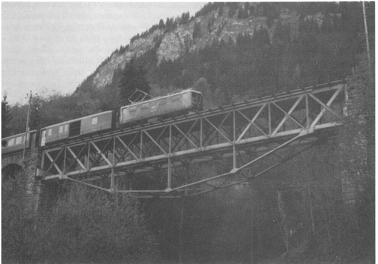
Die Hexentobel-Eisengitter-Brücke bei Serneus. Erbaut 1889/90. Kurz vor dem Ersten Weltkrieg wurde sie für die schweren elektrischen Lokomotiven durch Hängebögen und Verstrebungen verstärkt. Foto: Paul Caminada, Thalwil
