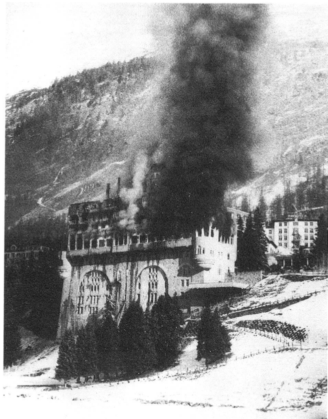
Grossbrand Schlosshotel Pontresina, 17./18. November 1981. Schaden rund 10 Mio. Franken. Foto: Felix Kaiser, Pontresina.
