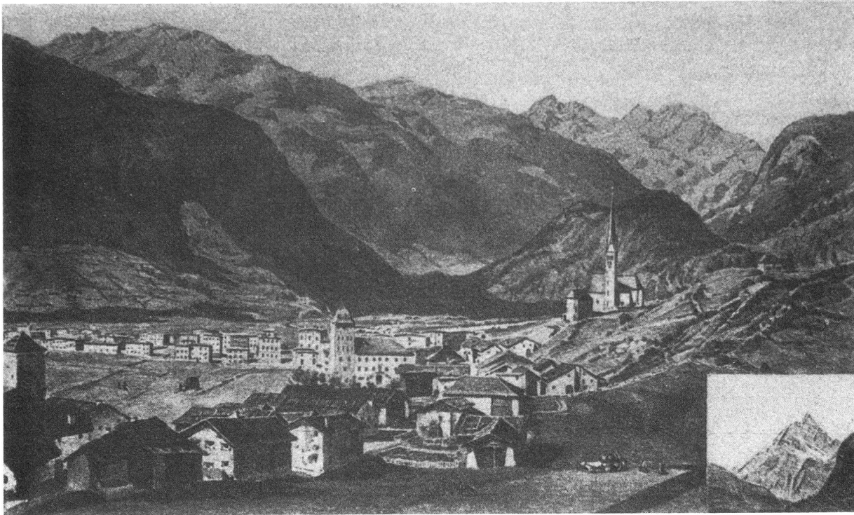
Zernez nach dem Brand. Der Wiederaufbau erfolgte grösstenteils mit Flachdächern. Damit hat das stattliche Engadinerdorf doch viel vom alten Glanz verloren. Foto: Rätisches Museum, Chur
