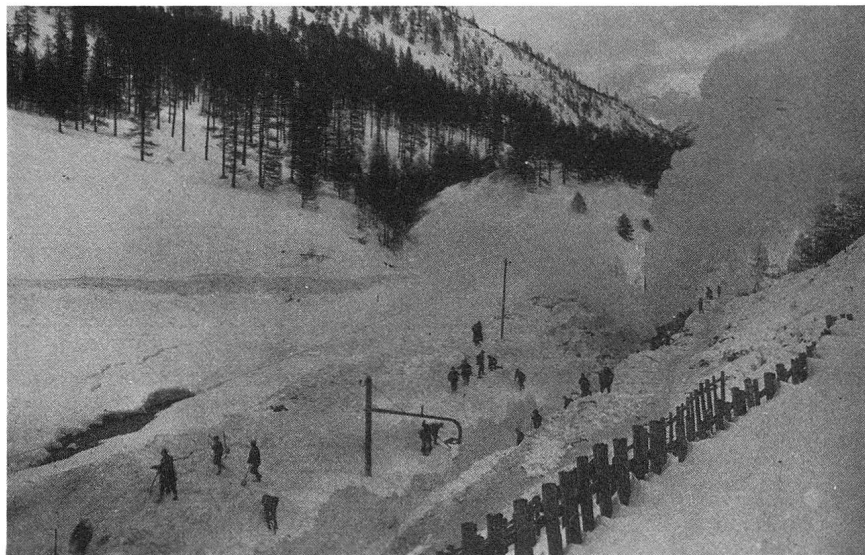
«Crasta-Mora»-Lawine Dezember 1919. Räumung der Bahnlinie mit der Schneeschleuder. Man beachte die Höhe des Lawinenschnees über dem Geleise. Foto RhB
