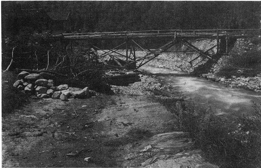
Hochwasser 1910. Ein von Sappeuren kurzfristig erstellter Notsteg vor Schiers.
