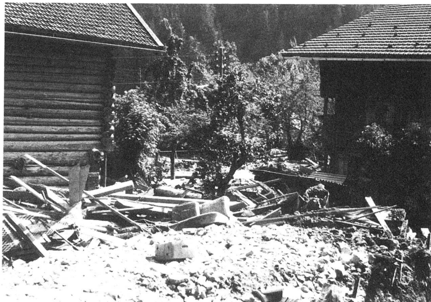
Die Rufe führte Schutt und Gebäudeteile mit sich, drang in Wohnhäuser und Ställe ein und überschüttete Hausgärten und Kulturland.
