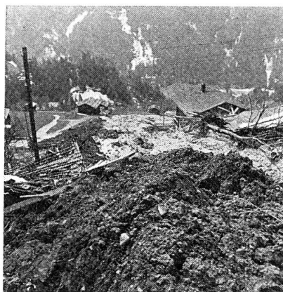
Murschutt zwischen Tal- und unterer Dorfstraße. Auch das Bahnhofsträßlein ist meterhoch zugedeckt.
