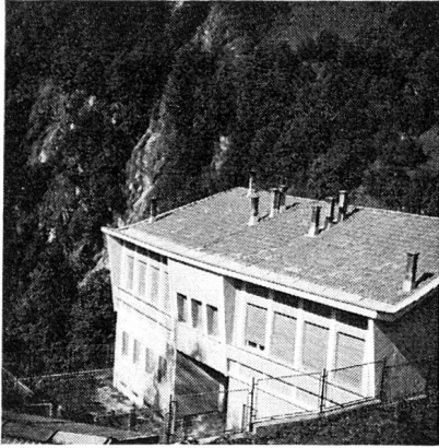
Das neue Schulhaus von Savogno. Die Rolläden sind meist heruntergelassen, da das Gebäude nur noch im Sommer kurzfristig zu Ferienzwecken benützt wird.
