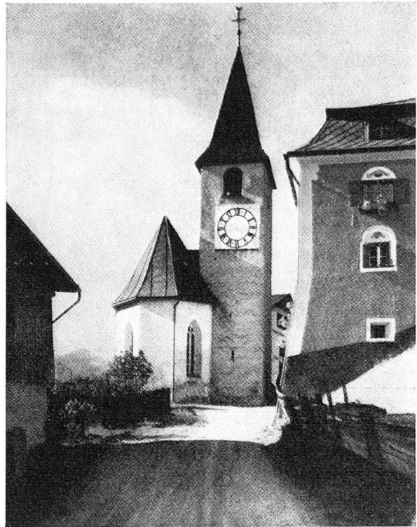
Das Chor unserer Kirche mit Turm. Das Chor — die einstige Kapelle St. Sebastian — wurde erst durch den Bau unserer Kirche um 1600 herum als deren Chor erschlossen. Diese bauliche Umstellung fand 1705 ihren Abschluß
