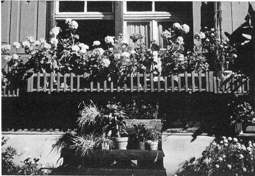
Stationsgebäude Cavadürli/Klosters. Phot. Furter
