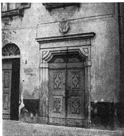
Bündens Amtsgebäude Pretorio mit Wappen von Chiavenna
