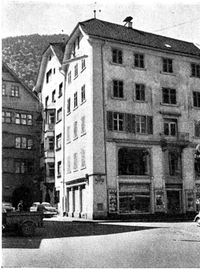
Anno 1902 wurden die mit der «modernen» Zeit nicht mehr harmonierenden alten Gewölbe in den Verkaufsläden entfernt. Die alten geschlossenen Rundbogenfenster wurden durch große Jugendstil-Schaufenster ersetzt, leider auch im 1. Stock. Die früher geschlossene Fassade gegen den Martinsplatz wurde dadurch aufgerissen
