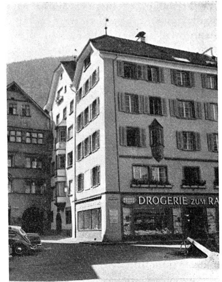
Der frühere geschlossene Hauscharakter ab 1. Stock wurde wieder hergestellt. 3 «blinde» Fenster wurden beseitigt. Der Erker im 2. Stock und die steinernen Fenstereinfassungen im 1. Stock stammen aus dem 1961 abgebrochenen Hause Wiget am Martinsplatz. Der allzu symmetrische Balkon im 2. Stock wurde entfernt
