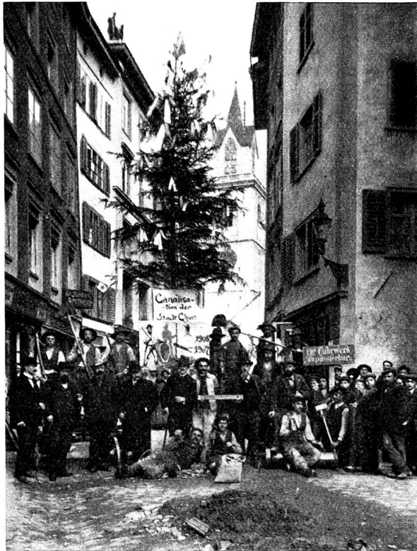
Die Erstellung der Kanalisation in den Jahren 1905-1907 erforderte namentlich in der Altstadt große bauliche Umtriebe.
