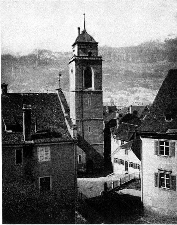
Eine nahe Aufnahme des Martinsturmes mit dem alten Helmdach.
