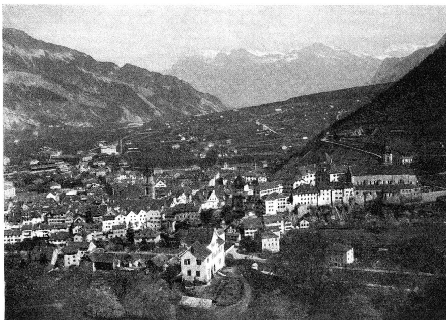
Eine Aufnahme von Chur aus den goer Jahren, nachdem größere Bauten bereits entstanden sind, so die Stickerie und die Neumühle im Wiesentalquartier sowie im Loequartier das Waldhaus, zu dem nunmehr die neu erbaute Loestraße hinführt.
